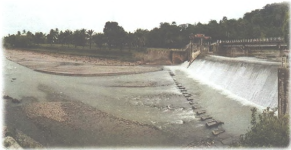
Gambar 4.37 Bendungan Pinto Sa Tiro
